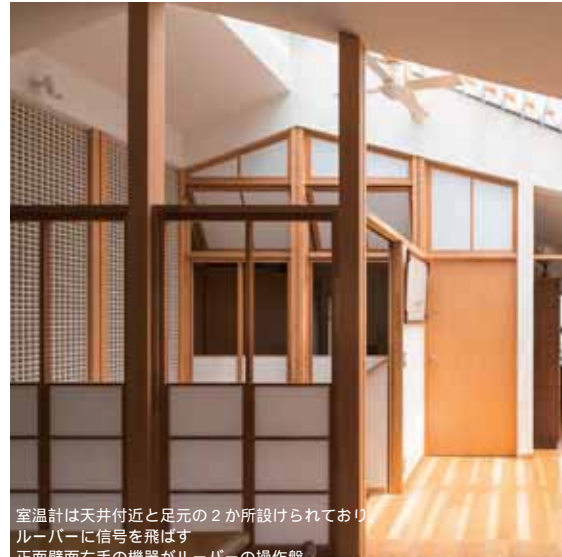
ガラス屋根には日射遮蔽係数の高いLow-E複層ガラスを採用
