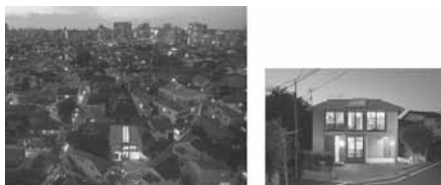
ガラス屋根を通して天空と室内とで放射エネルギーを交換する「宙の家」
